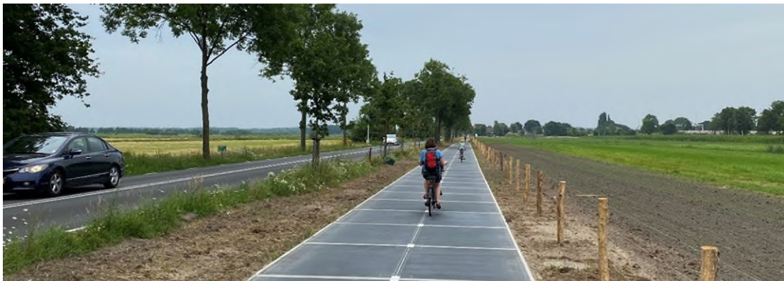
Figuur 7.1 Voorbeeld van een slimme combinatie: zonnepanelenfietspad (Maartensdijk)
