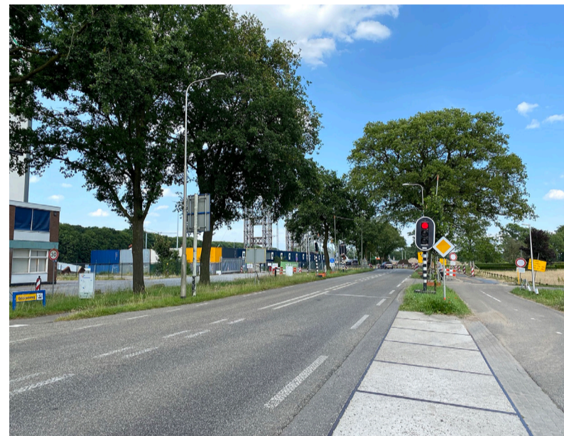
Op meerdere momenten van de dag kan de Goorseweg afgesloten zijn. Dit heeft te maken met het opruimen van de beschadigde delen van de brug.
